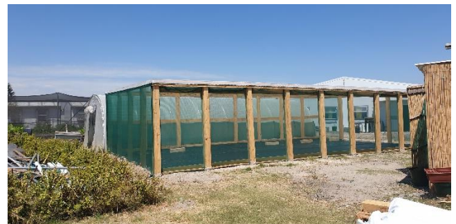
Das neue Gebäude für die zukünftige Hydroponik Anlage
